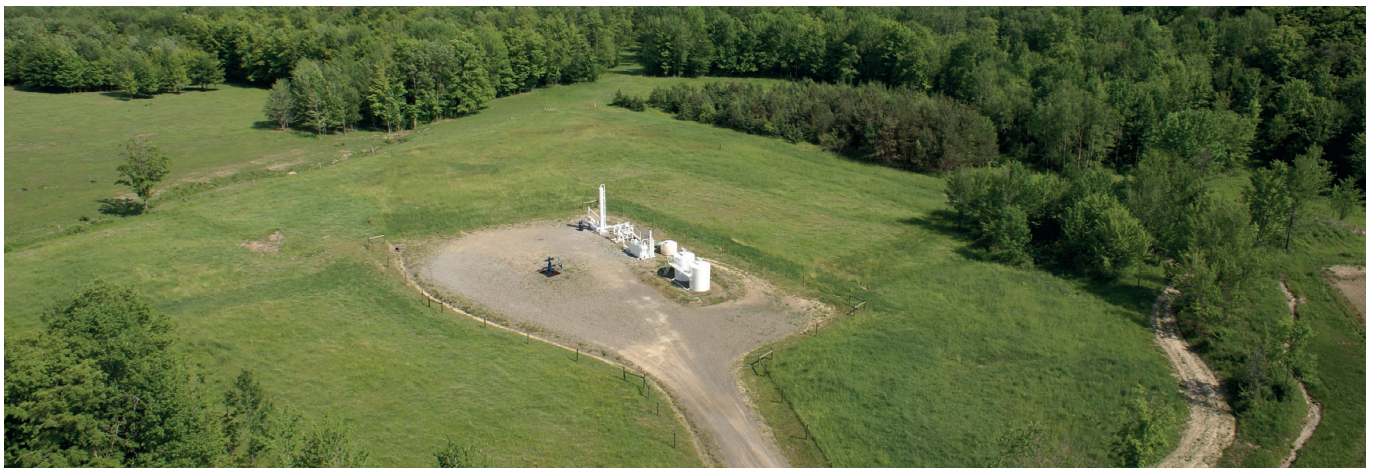
EMPLAZAMIENTO DE UN POZO DE GAS NATURAL. EE.UU.
